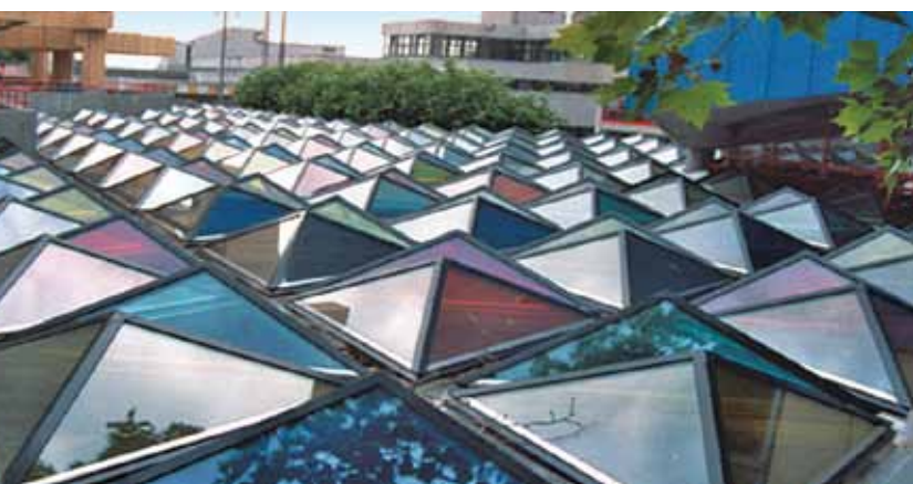
Revêtements de murs sur le toit pyramidal classé monument historique, Université de Constance
