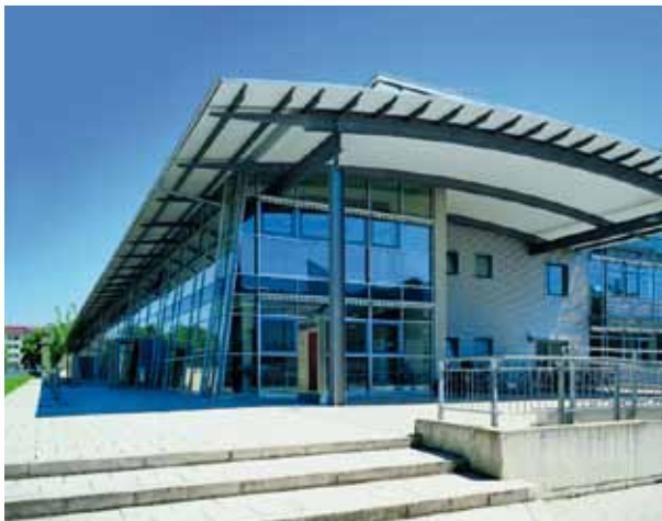
Etanchéité de la façade de l'école supérieure de Rosenheim
