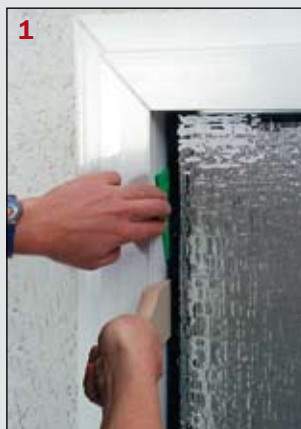
Figure 1 et 2: Montage de la cale côté fermeture
