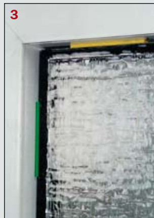
Figure 3: Coin calé d'une fenêtre oscillo-battante
